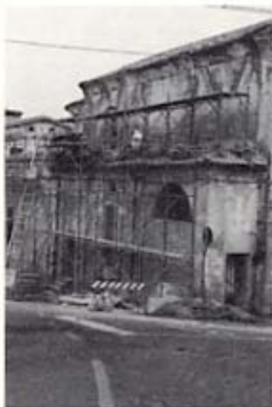
Rifacimento dell'itoraco esterno.
